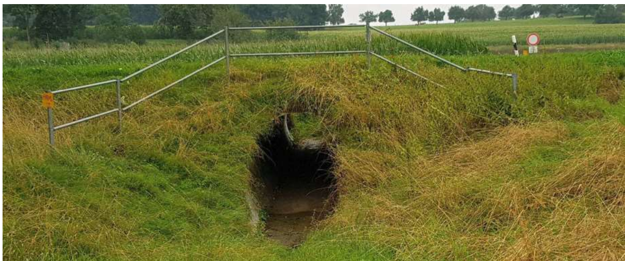
Viehtriebdurchlass unter der L267
