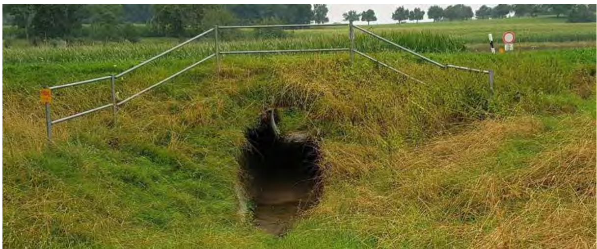
Viehtriebdurchlass unter der L267
